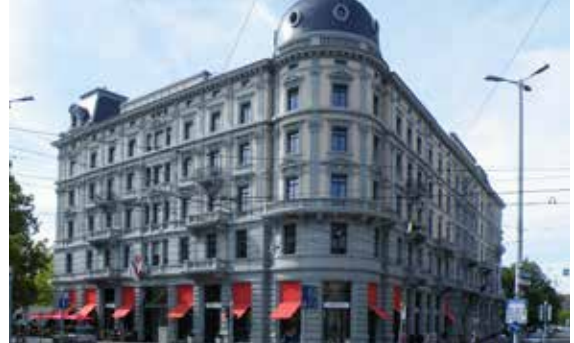
Bellevue, Zurich ext.: Fixit 670 Prégiclage chaux-ciment, Fixit 662 Enduit de fond conv., Fixit 777
