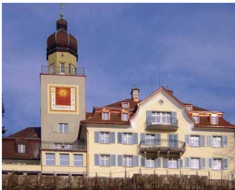
Château Heerbrugg Stucanet chevillé, Fixit 666 Enduit de fond léger, FIXITherm.roc avec Fixit 433, Fixit 777 Ribage précieux
