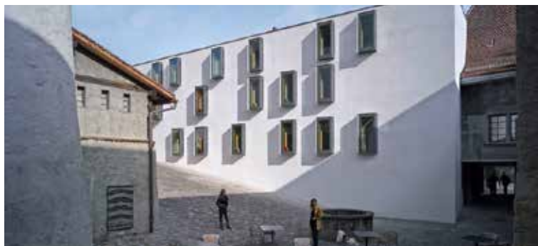
Château de Thouné extérieur: grande façade ouest de 350m 2 isolée avec Fixit 222, conformément aux directives sur les monuments historiques
