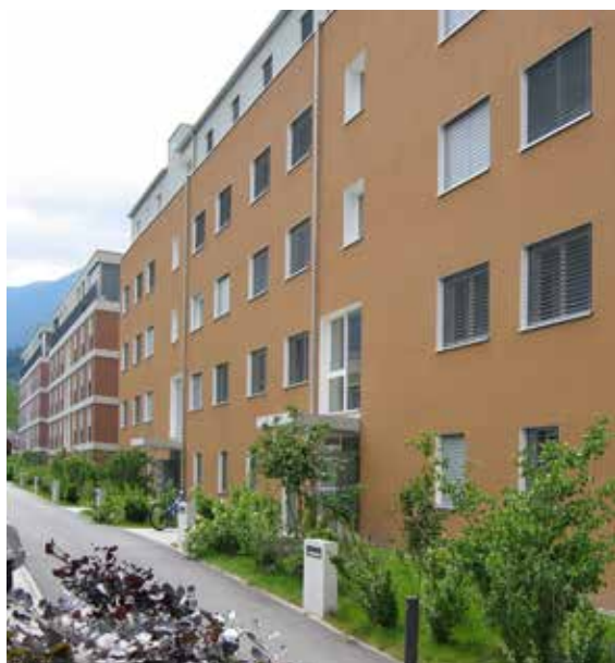
Immeuble Güterstrasse, Coire ext.: FIXITherm.eps, Fixit 710 Crépi de finition synth., int.: Fixit 180 et Fixit 610
