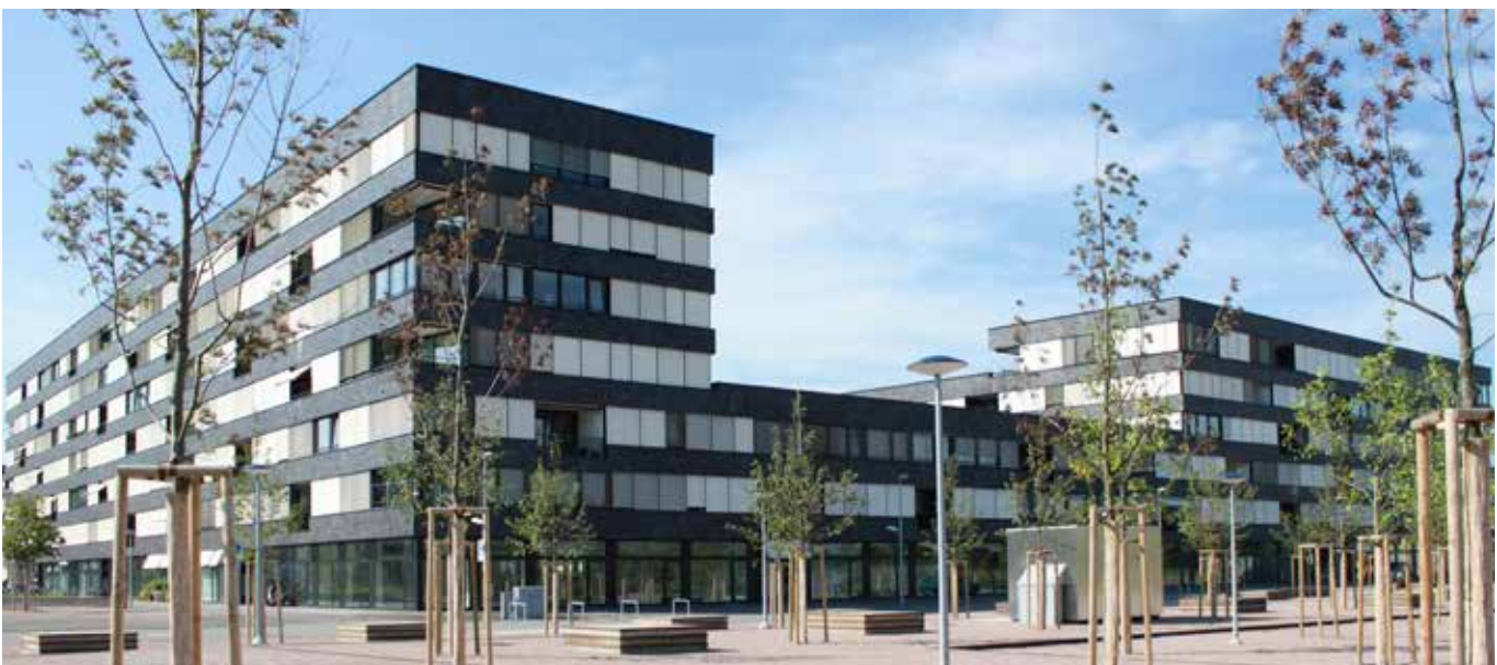
Lotissement Erlentor, Bâle int.: Fixit 160 et 166 Enduit plâtre à la machine, Fixit 341 Pont d'adhérence R+S, Fixit 475 Couche de fond pour crépis minéraux, Fixit 775 Riboge intérieur extrablanc
