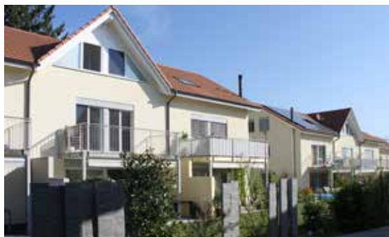
Immeuble, Möhlin ext.: FIXITherm.roc, Fixit 732 Crépi de finition au silicate APS, int.: Fixit 166 et 180
