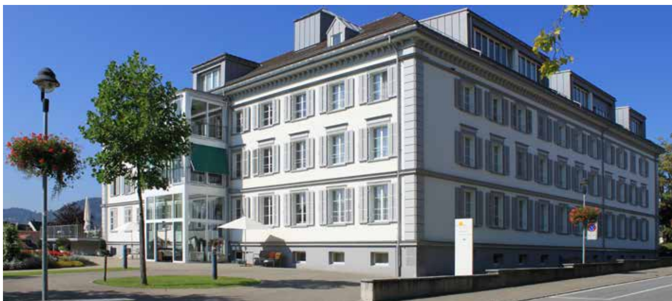
Fondation Maison de retraite Ebnet, Herisau FIXITherm.roc avec crépi de finition au silicate, Fixit 688 Enduit thermo-isolant, Fixit 777 Ribage précieux 2 mm, int.: Fixit 610 Enduit de fond chaux-ciment, Fixit 142 Enduit lisse et Fixit 777 Ribage précieux
