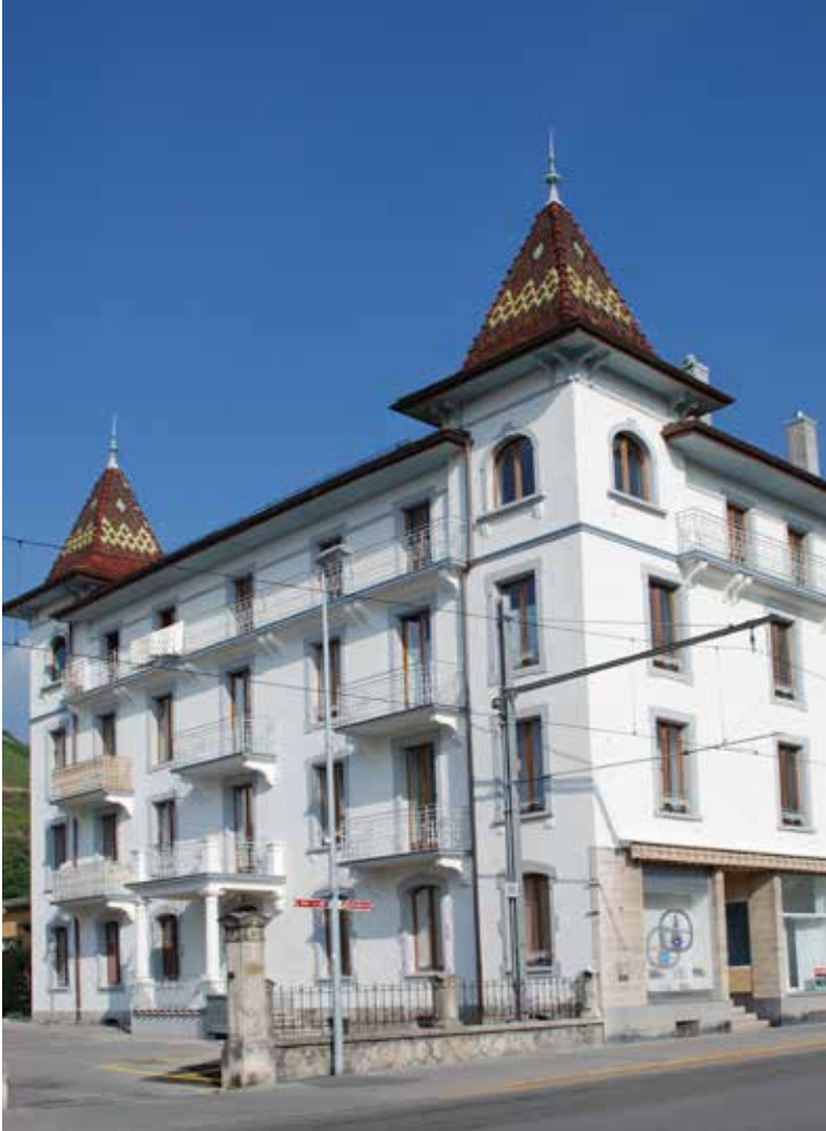
Gare de Bex VD ext.: Fixit 565 Mortier de jointoiment, Fixit 205 Enduit de fond, Fixit 202 Crépi de finition, Fixit 784 Peinture garn.
