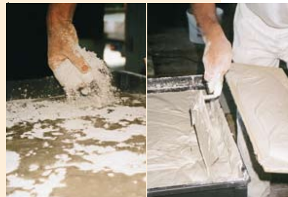
Avant l'application du pont d'adhérence, la teneur en humidité autorisée d'un support en béton est de max. 3 % de la masse.
