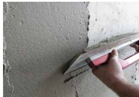
Appliquer un spatulage d'assainissement
