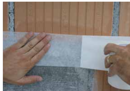
Coller le non tissé de séparation
