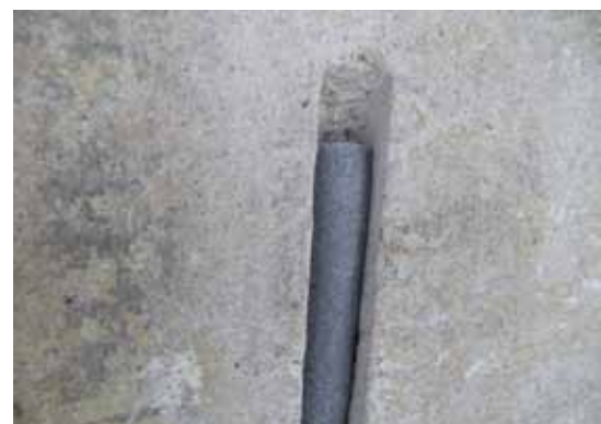
Placement du profilé en mousse
