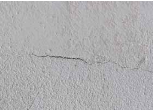
Fissure d'affaissement
