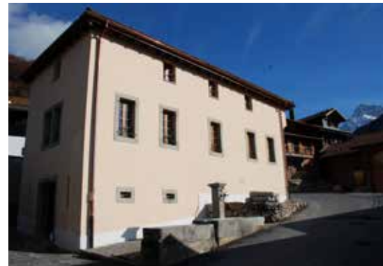
Maison Forte après l'assainissement, Chêne-sur-Bex
