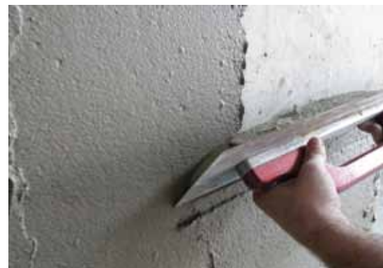
Appliquer un spatulage d'assainissement
