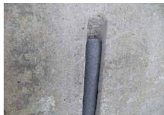
Placement du profilé en mousse
