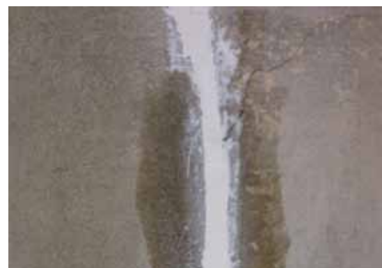
Mastic acrylique lissé
