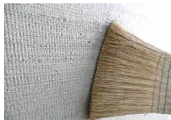
Zwischenschicht aufreissen
