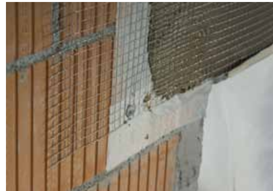
Armanet montieren
