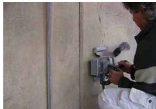
Parallelschnitt einfräsen
