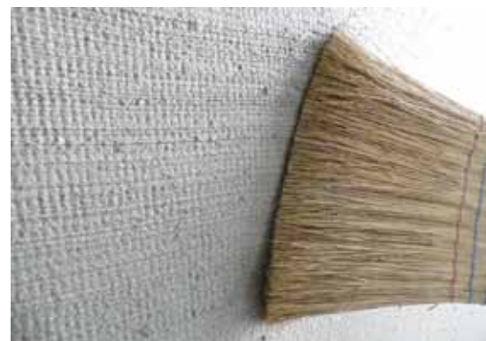
Zwischenschicht mit Besen aufreissen
