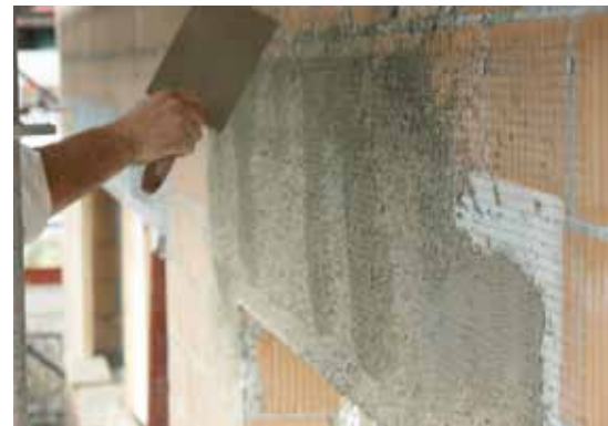
Zementmörtelanwurf
